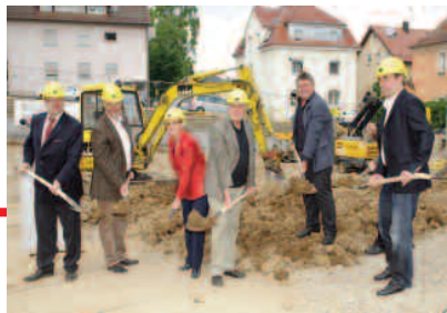
Baggerbiss für den Neubau Illerstraße 19/21 im Rahmen der Innenstadtentwicklung
