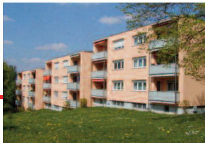
Typische Siedlungsmaßnahme der 70er Jahre im Rahmen des öffentlich geförderten Wohnungsbau, Balthasar-Neumann-Straße in Stuttgart-Freiberg
